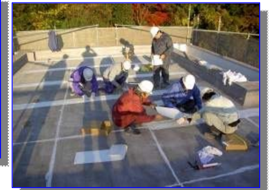
第2回 スキル講習会(防水・防錆)
