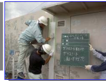
スキル講習会 実施(防錆) 岐阜県で美濃川部交換改修工事にトライ!
