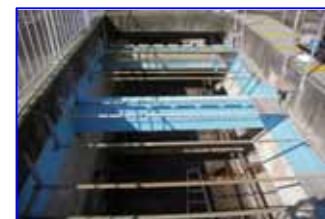
下水処理場内トラフ 防藻工事
