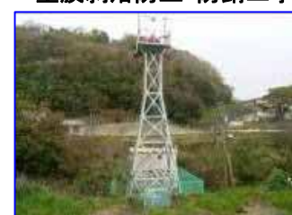
国道河川警報鉄塔 塗膜剥落防止・防錆工事
