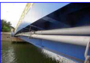
橋梁添架(通信光ファイバー保孔管) 紫外線防護・防錆工事
