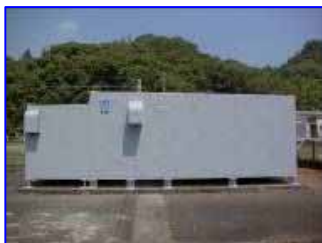
遠隔收容装置用收容箱(RT-BOX) 遮熱・防錆・補強工事
