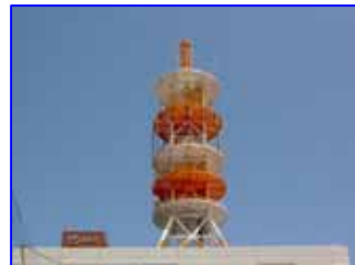
屋上通信鉄塔 塗膜剥落防止・防錆工事
