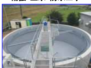
新設汚水沈殿槽 防食・止水工事
