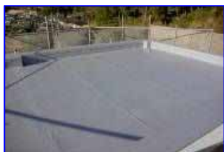
屋上防水 遮熱・防水工事
