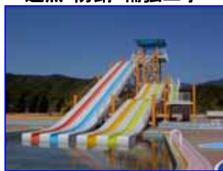
ウォータースライダー 塗膜剥落防止・防錆工事
