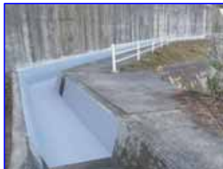
農業用水路 補強・止水・防水工事
